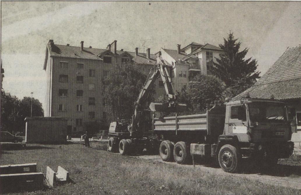
Delavci Cestnega podjetja Murska Sobota so začeli z izkopom trase dovozne ceste.
