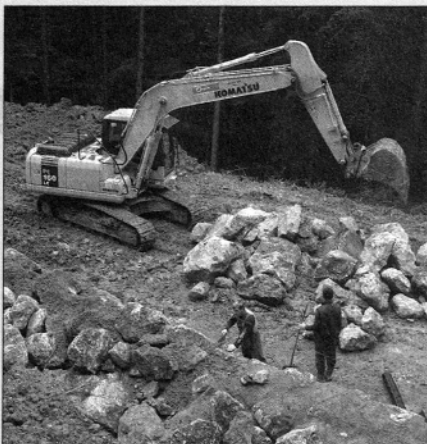
V podporne škarpe bodo vgradili velike skale in beton (foto: Jože Miklavc)
