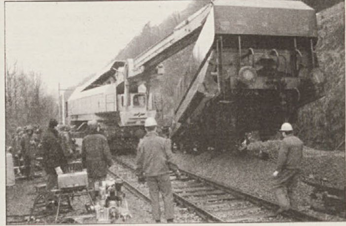
Zadnje štiri vagonje je delavcem uspelo spraviti iz proge s posebnim dvigalom čigar nosilnost je 120 ton. Kljub temu so najprej morali iz vagona odstraniti 60 ton železove rude.
