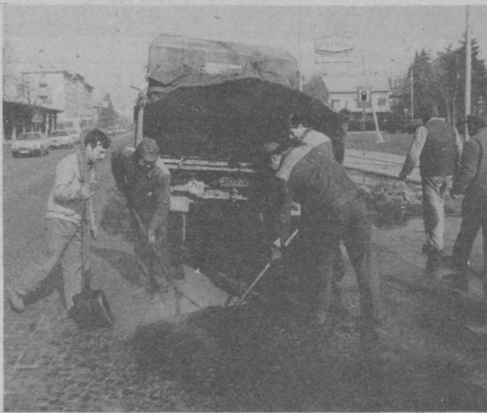
Na bežigraski magistrall delavci Cestnega podjetja krpa jo luknje, ki jih je napravila zmrzal. Spomladi pa bo Titova cesta postala večje gradbišče: od štadiona do križišča s severno obvoznico bodo položili novo asfaltno prevleko.
