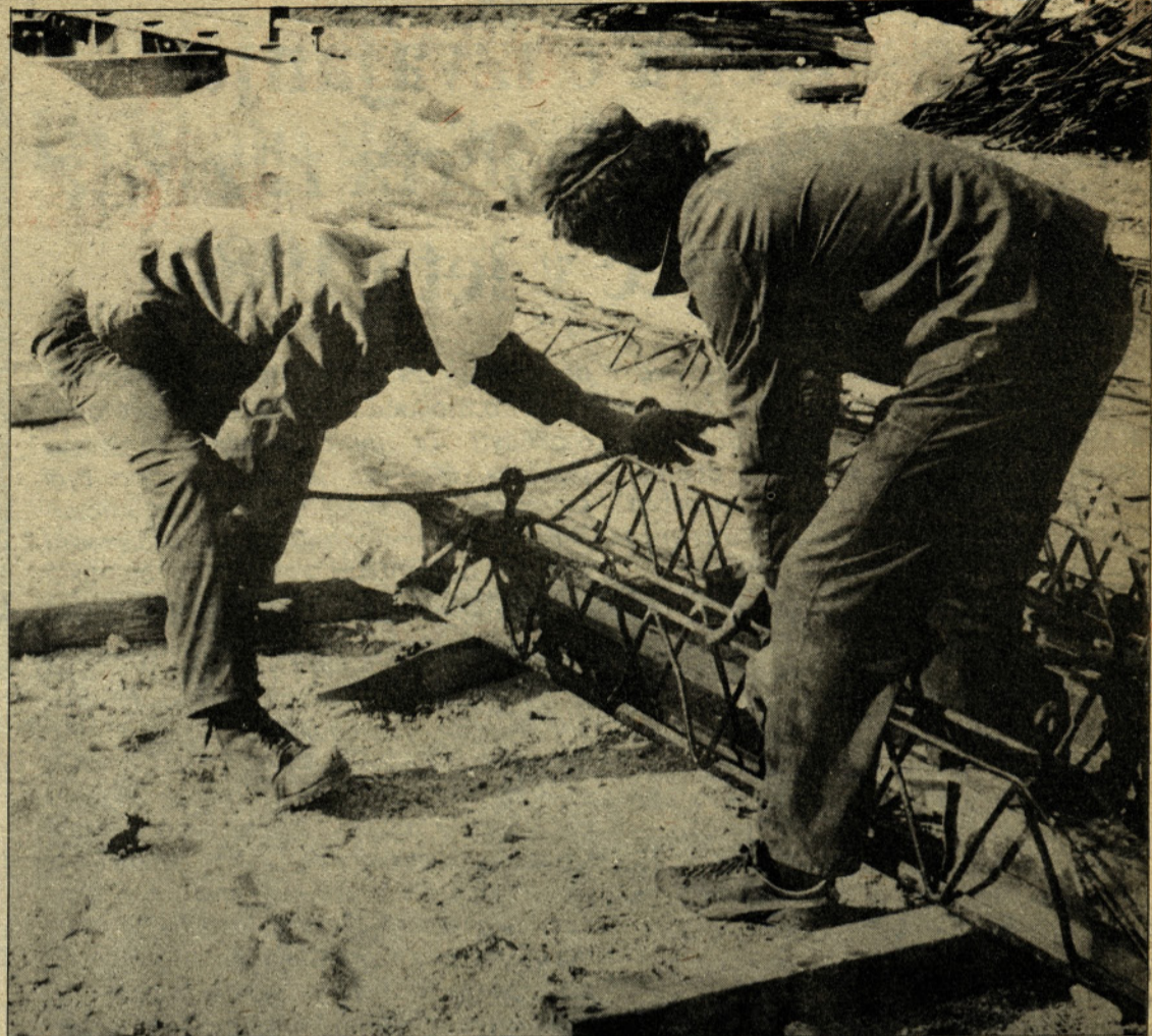
Detalj z gradbišča
