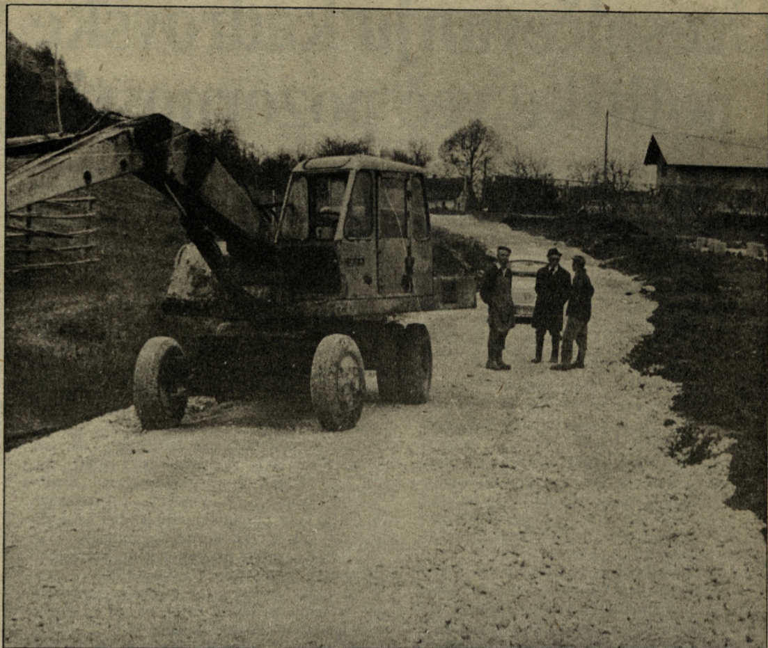
Delo na cesti Šentilj – Podkraj. Krajanje bi radi cesto še pred zimo asfaltirali
