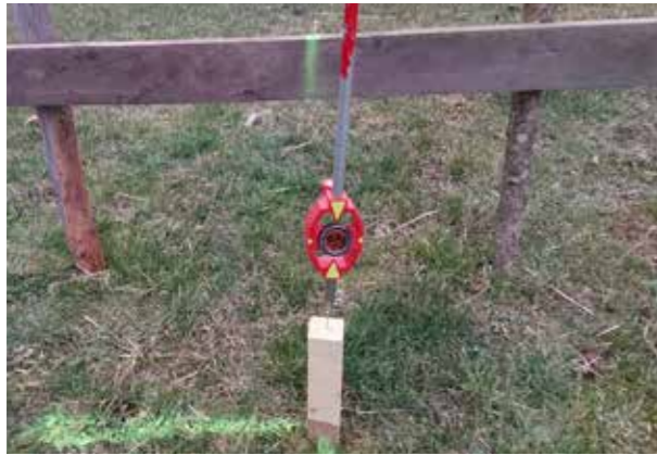
Natančna označitev vogalne točke objekta na lesenem količku. The corner of the building marked with nail in a wood stake.
