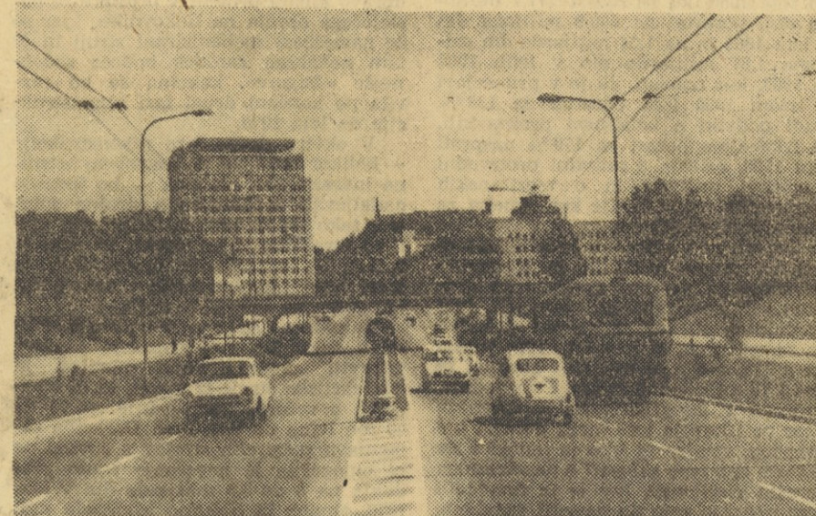
Podvoz na Celovski cesti
