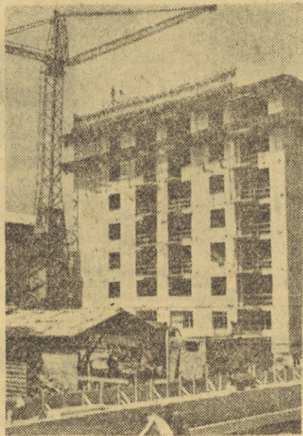
Nova stanovanjska stolpaica na Jami v Šiški — izvajalec del je »Gradis«
