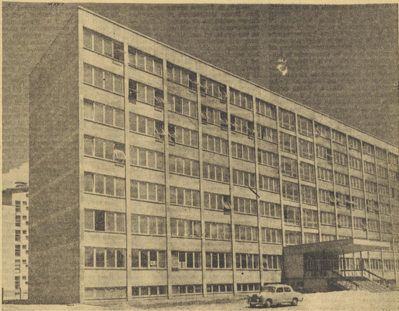
Novozgrajeni objekt Tovarne aparatov in instrumentov »VEGA« v Ljubljani, Kotnikova 18
