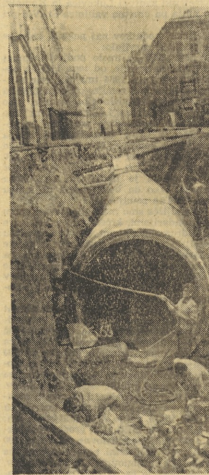
Dela pri urejanju kanalizacije na Trgu revolucije v Ljubljani
