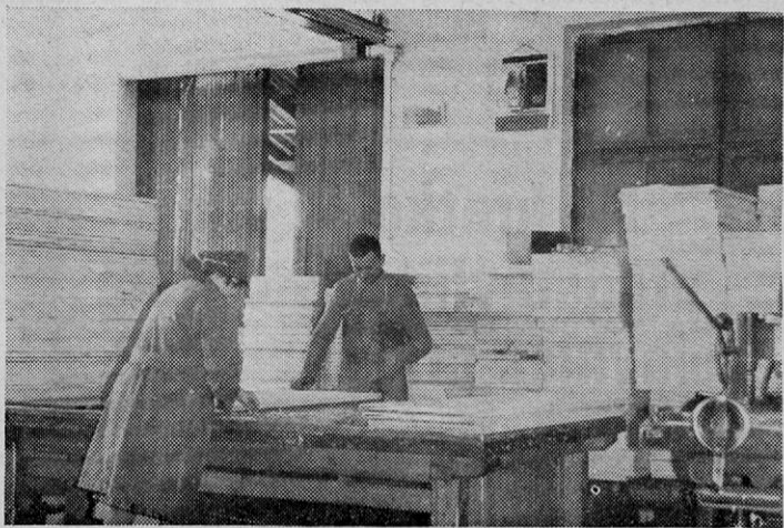
Kovanje gradbenih plošč.
