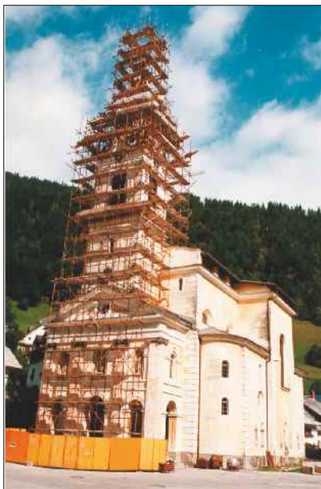
Zahtevna odrska konstrukcija v fazi izvedbe rekonstrukcije strehe zvonika in obnove vhodne fasade. Foto: Aleksander Čufar
