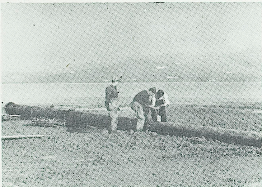
Daleč v Skočjanski zaliv, kjer je še pred kratkim valovalo morje, se že po kopnem vije cevovod. Skozenj potiska Peter Klepec zemljo in kamenje z morskega dna v bodočem koprskem pristanišču. Doslej je tako nasul za novi nasip že nad 70.000 ton materiala
