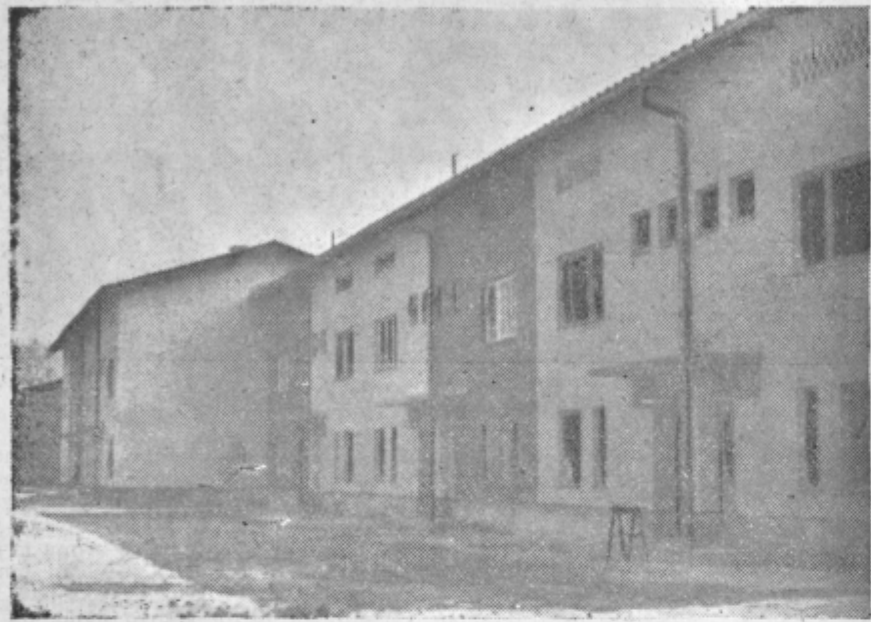
Prva zgotovljena zadruga hiša na »otoku« v Celju
