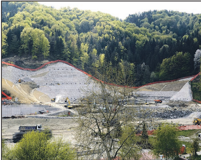
Gradbena dela uspešno napredujejo, vsak dan »odstranijo« dva tisoč kubičnih metrov zemlje.
