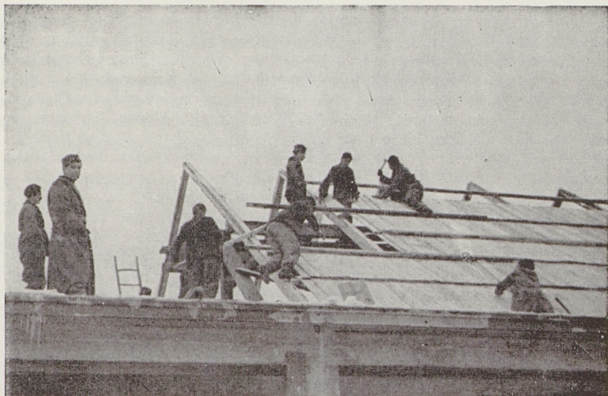
Dvorana bo kmalu pod streho
