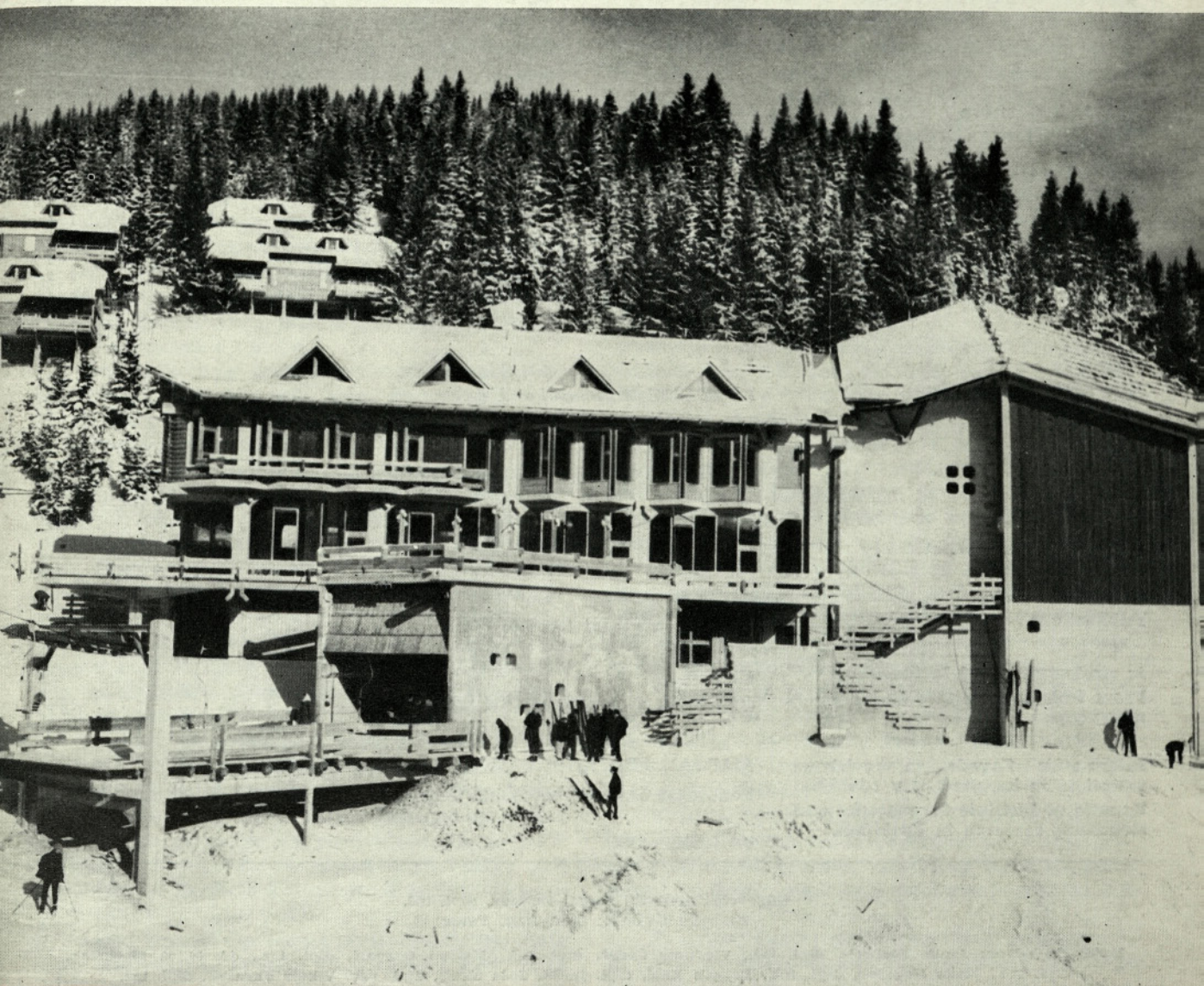
GIP »GRADIS« gradbeno vodstvo Celje: Gradnja zimsko-športnega turističnega centra »Golte«
