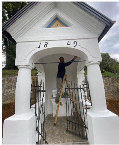
Mojster Štefan Kek pri zaključnem pleskanju foto P. Mrvar
