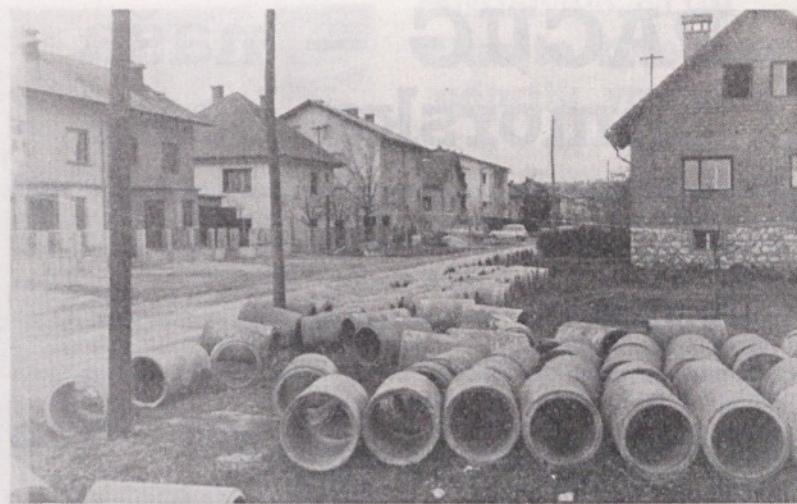
Polaganje kanalizacije na Vipavski ulici
