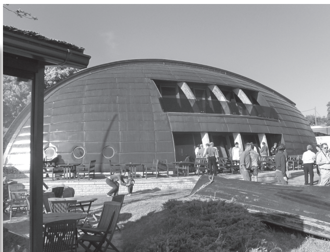
□ Slika 4. Restavracija z leseno konstrukcijo v obliki narobe obrnjenega ladijskega trupa ob Baltskem morju
