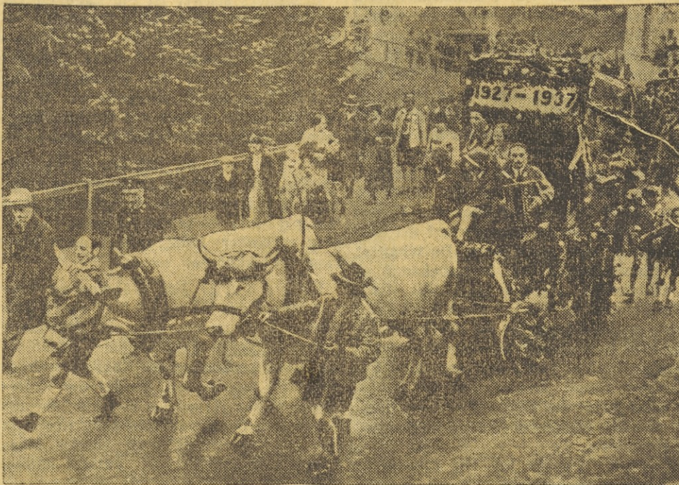
Auf dem Semmering bei Wien wurde soeben die neue Höhenstraße mit einer Feier dem Verkehr übergeben. Aus diesem Anlaß wurde ein Festzug veranstaltet, dessen Wagen zum ersten Male die neue Straße befuhren (Scherl-Bilderdienst-M.)
