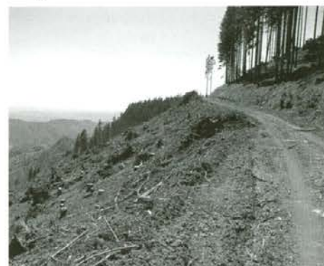
Za sanacijo vetrolomov so pomembne gozdne prometnice
