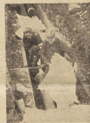
Delavci podjetja »Izolit« oblagajo te dni toplotne cevi v novih ljubljanskih kolektorjih s stekleno volno, ki jo danes vse bolj uporabljajo kot sredstvo za toplotno izolacijo. Steklena volna pa je — kot pove ime — steklena, s steklom pa se lahko urežemo. V tem primeru — poškodujemo roke. Zato smo tem bolj osupli, ko slišimo razumljive priroče delavcev, da podjetje ne zmore sredstev za nakup nujno potrebnih zaščitnih rokavic, ki bi jih morali imeti pri tem delu
