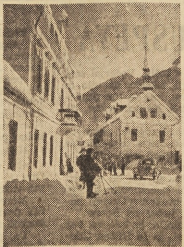
Stari hotel »Razor«, ki ga prav zdaj dokončno preurejujejo
