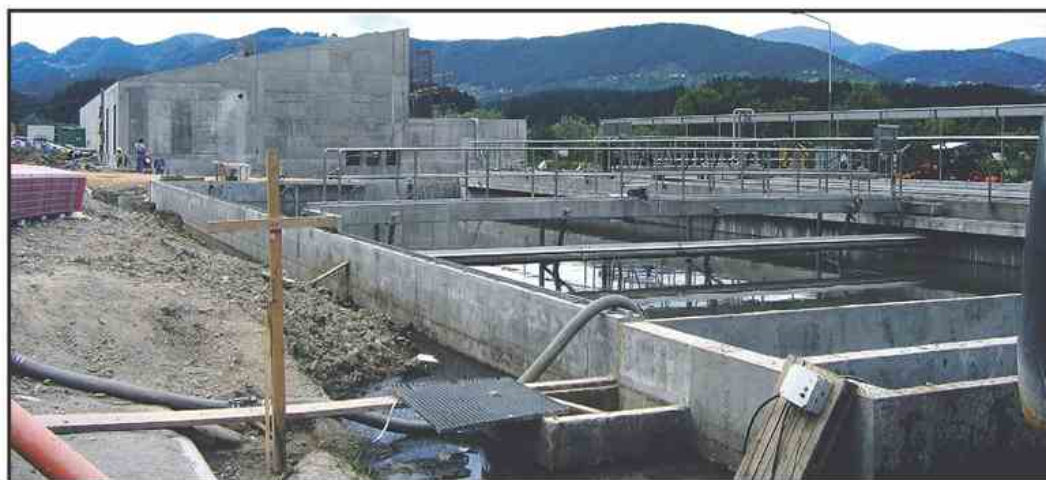
Predvidena dela pri obnovi mehanskega in izgradnji biološkega dela centralne čistilne naprave so v tem času v polnem zamahu
