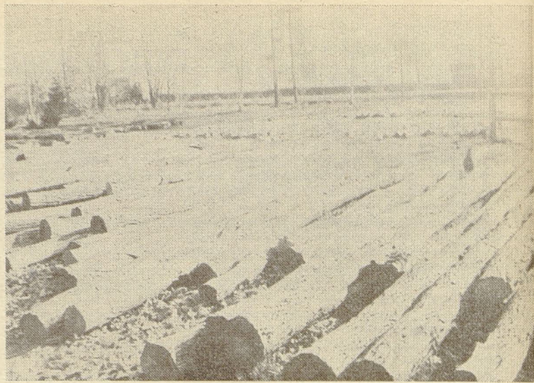
V Sempetru pripravljajo drogeve za veliko hmeljsko žičnico pri nadvozu
