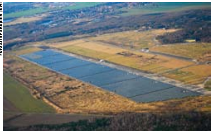
Pogled na del sončnega parka Waldpolenz.
