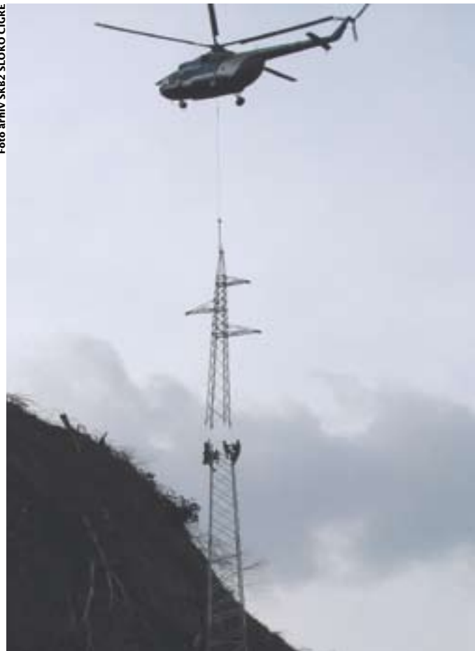
Primer helikopterske gradnje daljnovodnih stebrov.
