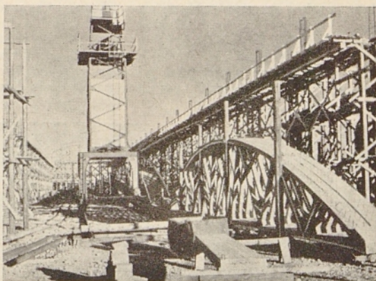
Litostroj gradi nov objekt
