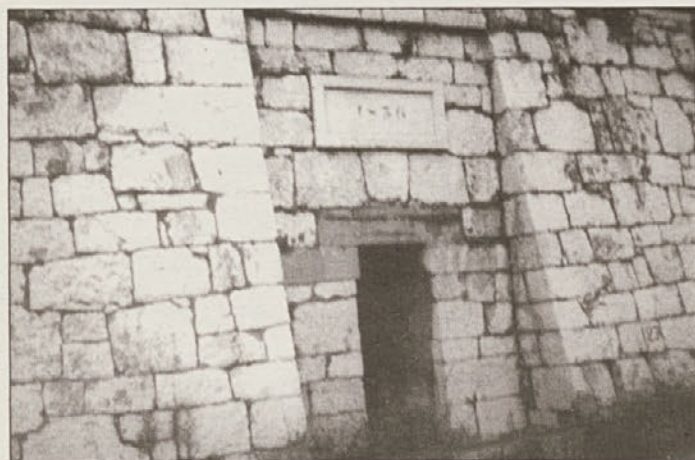
Oporni zid zgrajen 1836. leta.
