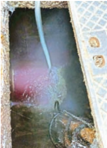
Mesto vzorčenja v Centru starejših Medvode / Foto: arhiv Čistilne naprave Domžale - Kamnik
