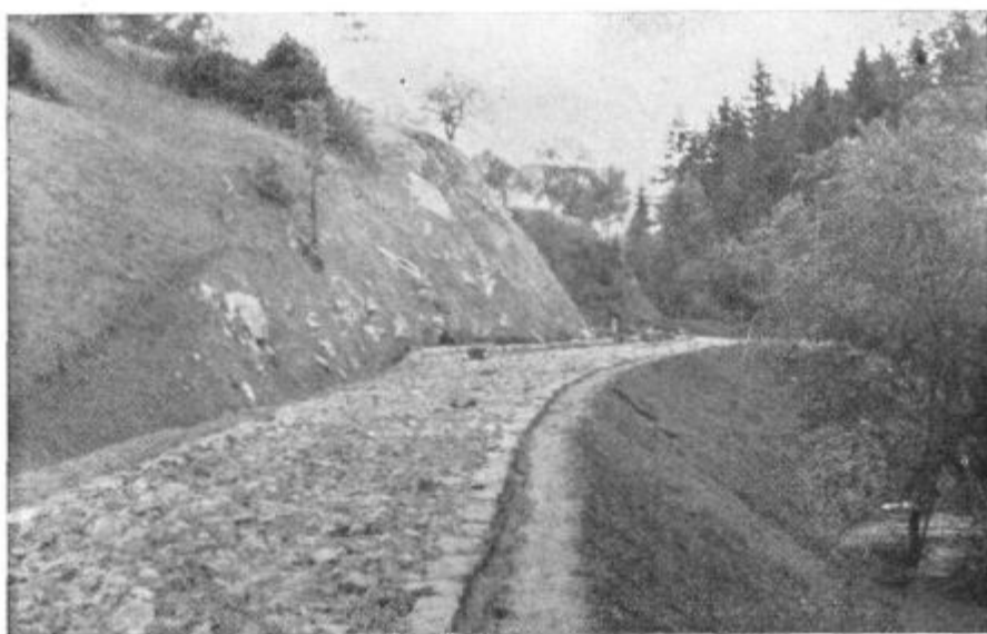
Pogled na odsek gozdne ceste Mozirje—Šmihel med gradnjo.
