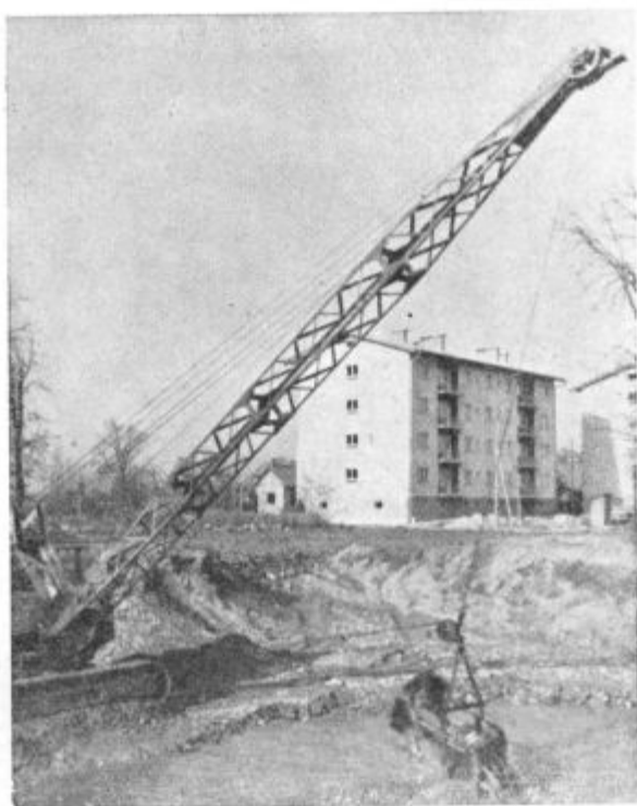
Prodna tla na Otoku (gradbena jama za stolpnico).
