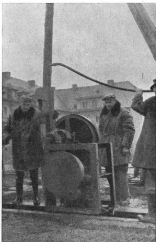
Vrtalna garnitura pri orientacijskem sondiranju celjskih tal leta 1956 (vrtanje ob Kersnikovi ulici).
