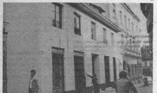
Predstavništvo Droge si je v Prečni ulici obnovilo staro zgradbo.
