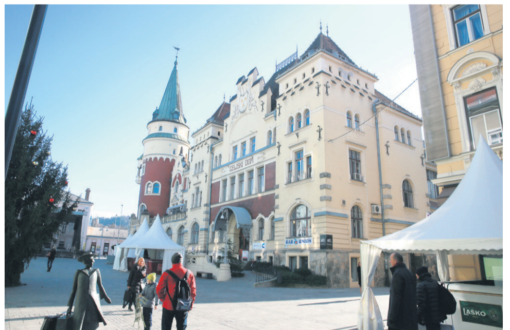
Arhitekturna znamenitost Celja: nekdanja Nemška hiša, danes Celjski dom. V prihodnjem letu bo stavba, ki jo je že načel zob časa, doživela temeljito energetska prenovu.
