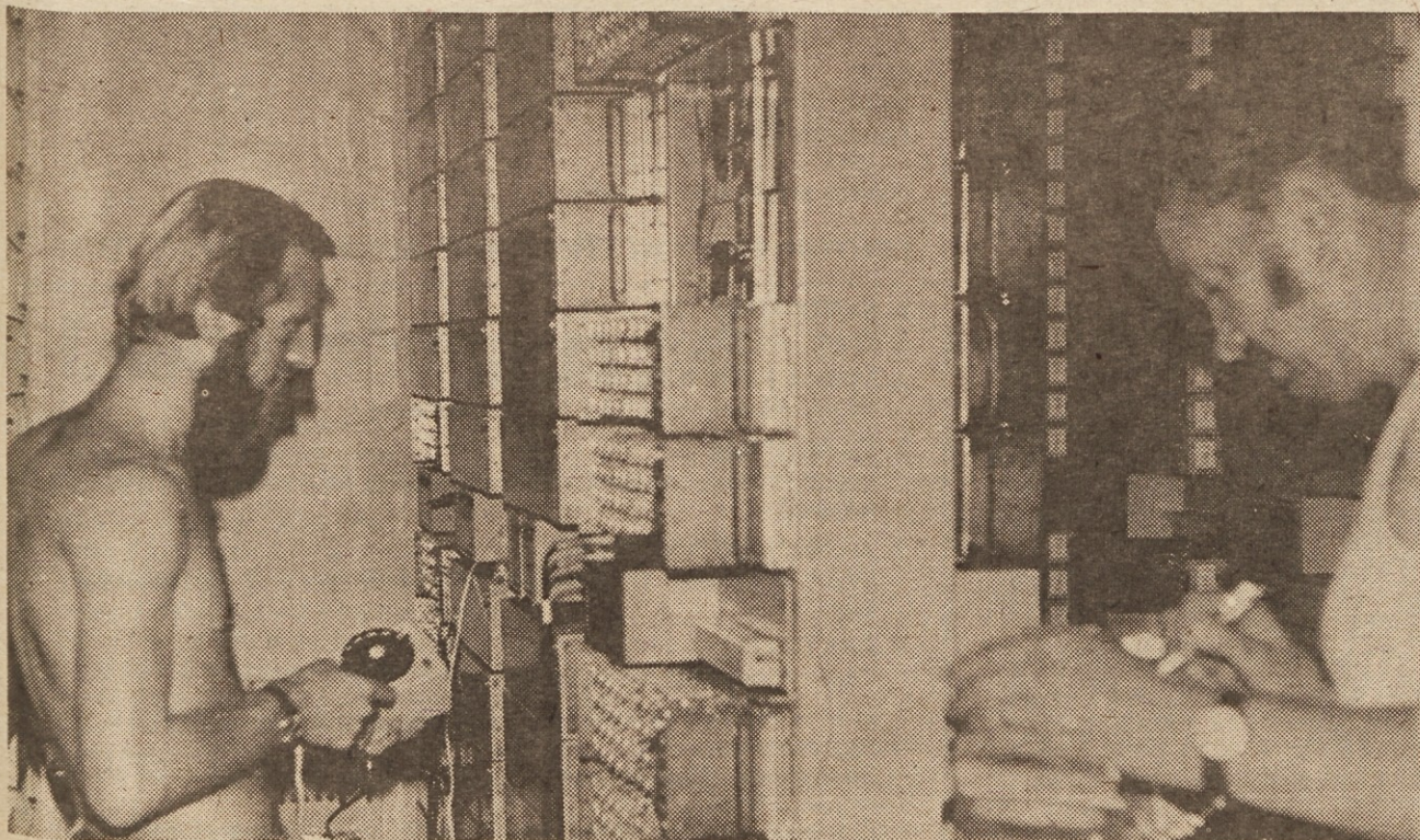
Preizkušanje prenosnikov pred vključitvijo v promet opravljata Franc Hribar in Ivo Franko – PTT Celje.
