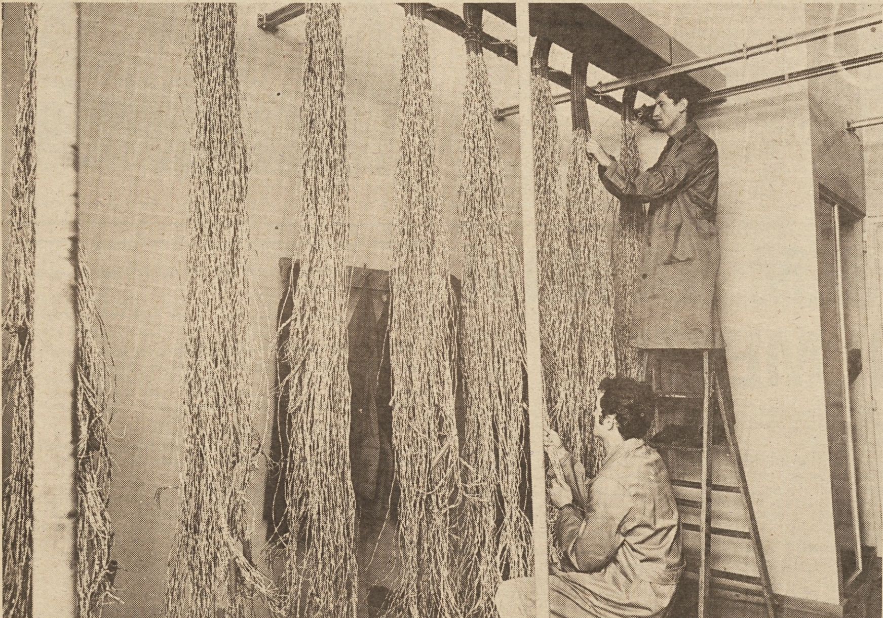
Priprava kablov za formiranje.
