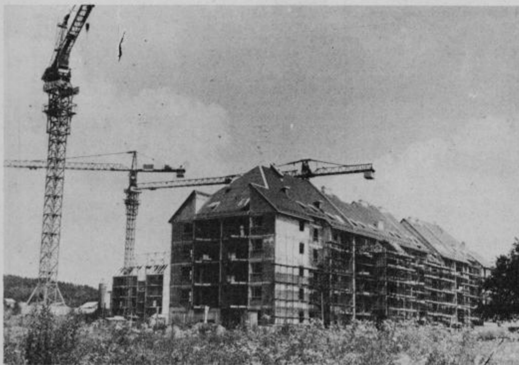
Gradnja družbenih stanovanj na območju zazidalnega okoliša Rabelčja vas zahod v letu 1982.
