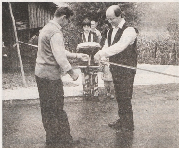
ASFALT NA ZAJČJO GORO - Za štiri domačije nad Ledganjem je bilo pravo veselje, ko je predsednik sevniske krajevne skupnosti Zvone Tuhtar prerezal trak (na posnetku) na cesti Ledganje-Zajčja gora, katera je dobila asfaltno podobo. Cesta je po strmini prava gorska, zato je bilo njeno vzdrževanje težko. Za te štiri domačije, kjer so doma predvsem upokojenci, je bil prispevek po nekaj več kot 300 tisočakov kar velik zalogaj, a danes ljudem ni žal. Preostali denar za asfaltiranje je prispevala KS Sevnica. (Foto: Jože Prah, ml.)
