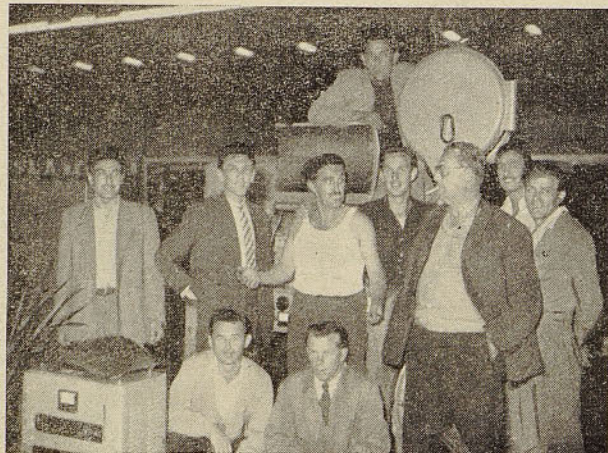
Delovna ekipa pri demontaži v našem paviljonu
