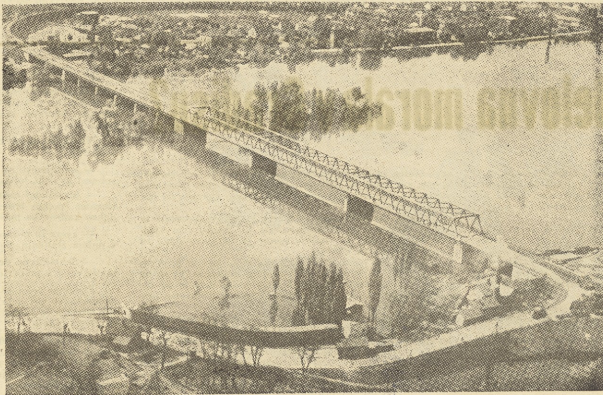
Le dolg nov most čez Savo loči Bosanski Brod od Slavonskega Broda. Naše gradbišče je na sliki desno
