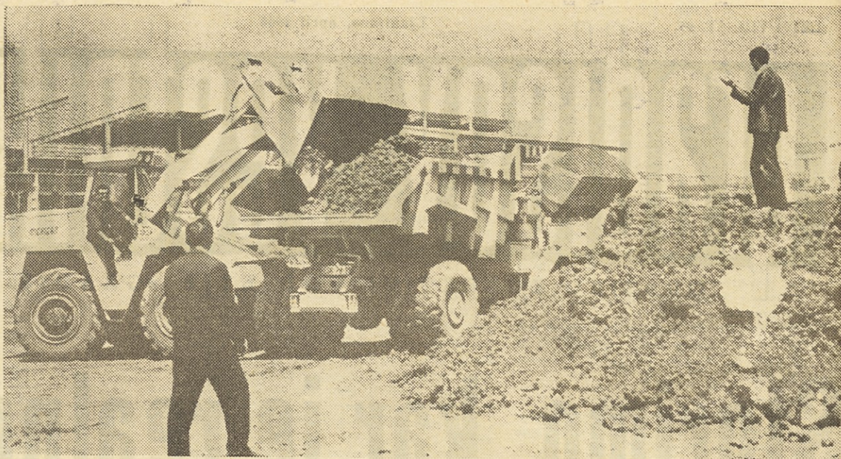
Za priučitev strojnikov se poslužujejo najmodernejših strojev. Na sliki strojniki na Michiganih.
