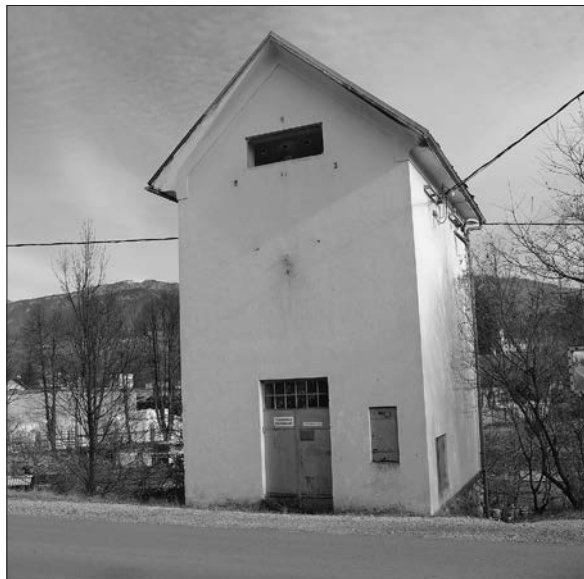
Transformatorska postaja danes (foto: Damjan Hančič).
