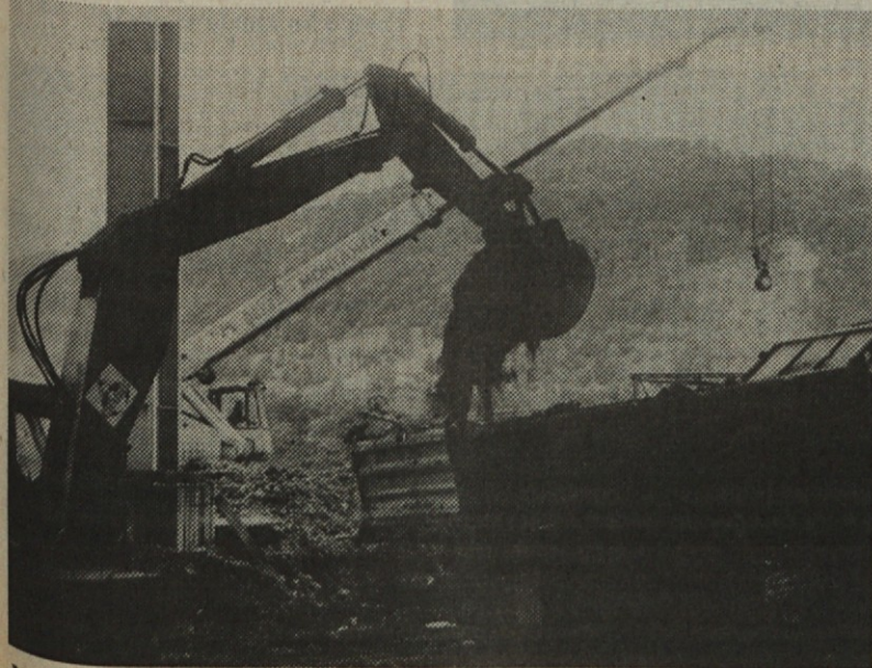
Na gradbišču Jeklarne 2 se dela z nezmanjšanim tempom
