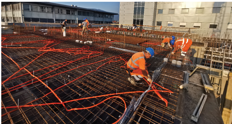
Slika 2. Plošča druge etaže nadgradnje, september 2021.
