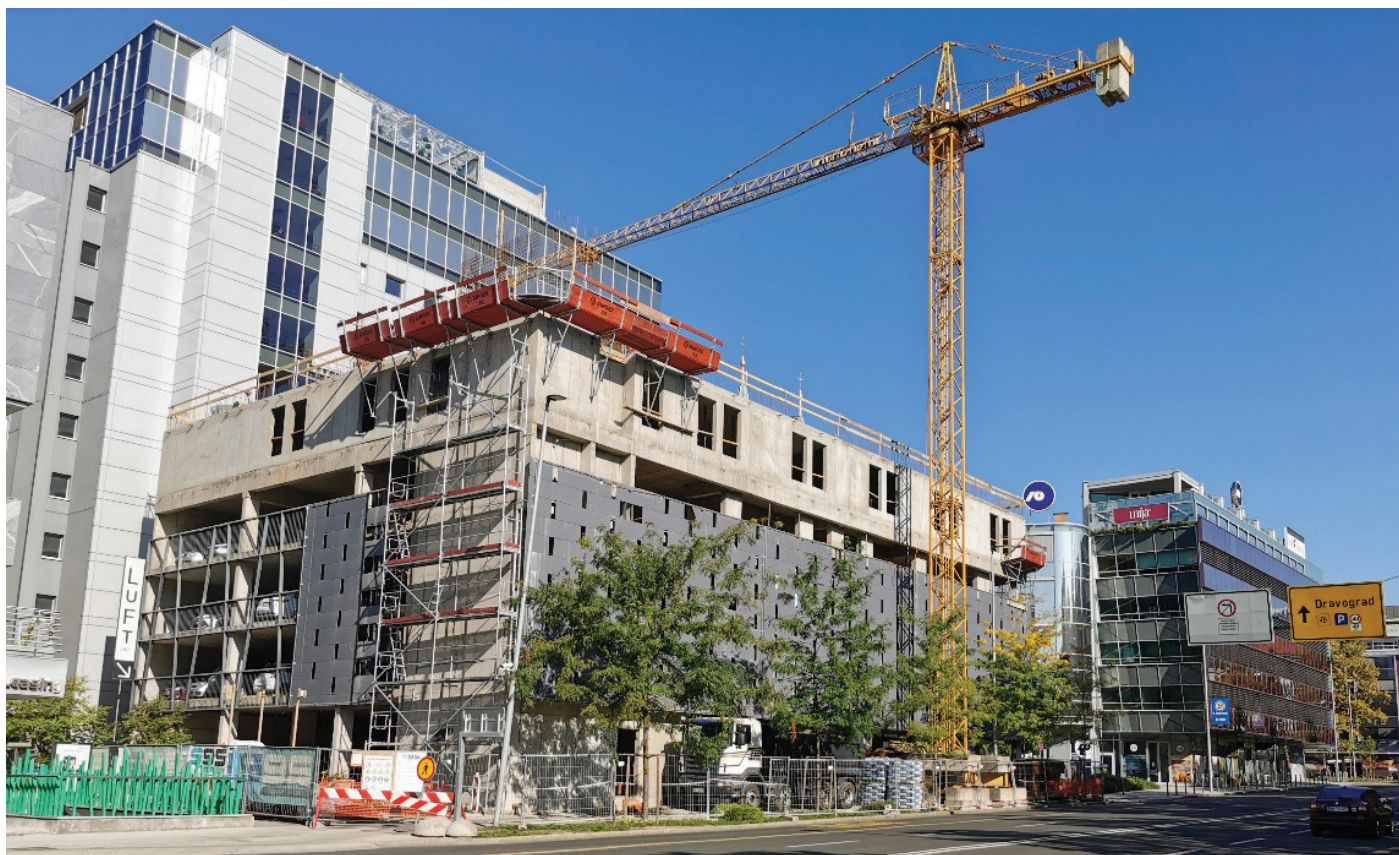
Slika 1. Obstoječa garaža in nadgradnja, avgust 2021.
