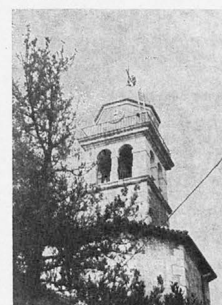
V Nabrežini so popravili strelovod na zvoniku
