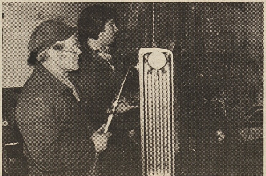
Kakovost strojnega varjenja je izredno visoka, zato le redkokateri radiator pušča. „Ujeli“ smo enega takšnega, ki ga je popravil Stanko Pestivšek.
