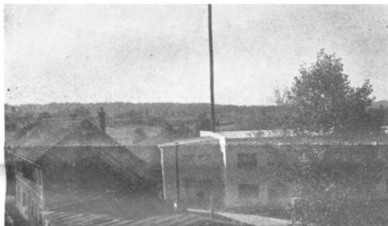
Tak je pogled na objekte nekdanje tovarne usnja, sedanjega obrata »Konus« v Slov. Konjicah. (Foto M. Brumen)
