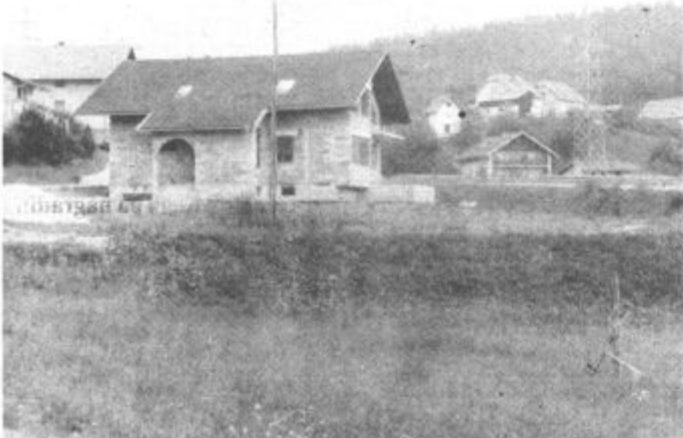
Krajanje Lokovice so se pri izgradnji vodovoda še posebej izkazali
