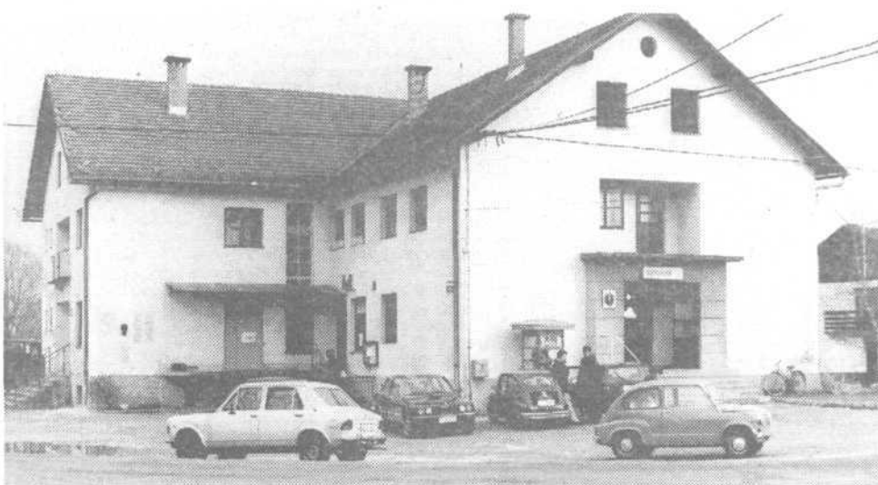
Zadružni dom so Barjani zgradili z udarniškim delom
