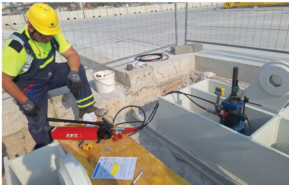
Slika 9. Napenjanje in testiranje sider.
