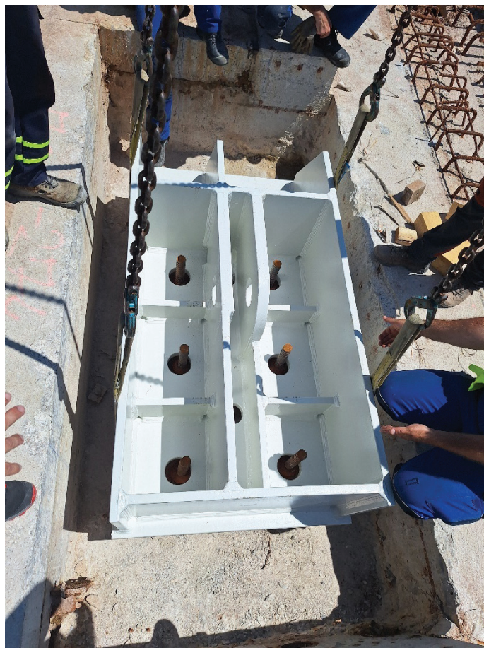
Slika 7. Injektiranje sider na privezu LS – »land side« (levo); nameščanje jeklenih elementov na vgrajena sidra (desno).
