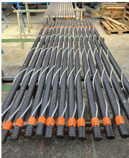
Slika 2. Sestava sidra v delavnici: levo – nameščanje distančnika za centriranje, desno – nameščanje zaščitne rebraste HDPE-cevi z oddušniki za injektiranje s cementno injekcijsko maso.
