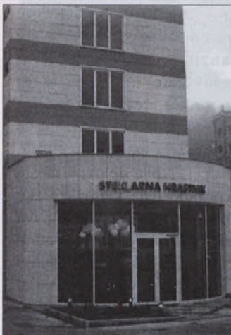
Obnovljen vhod v avlo poslovne stavbe
