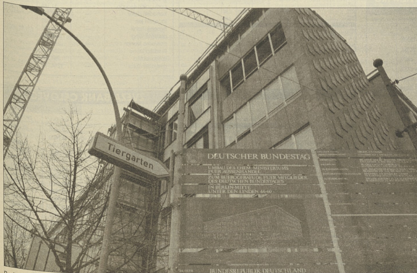
Berlin je eno samo gradbišče. Na vsakem koraku je videti zidarske odre, dvigala, zaščitne ograje (Foto: Srđan Živulović)
