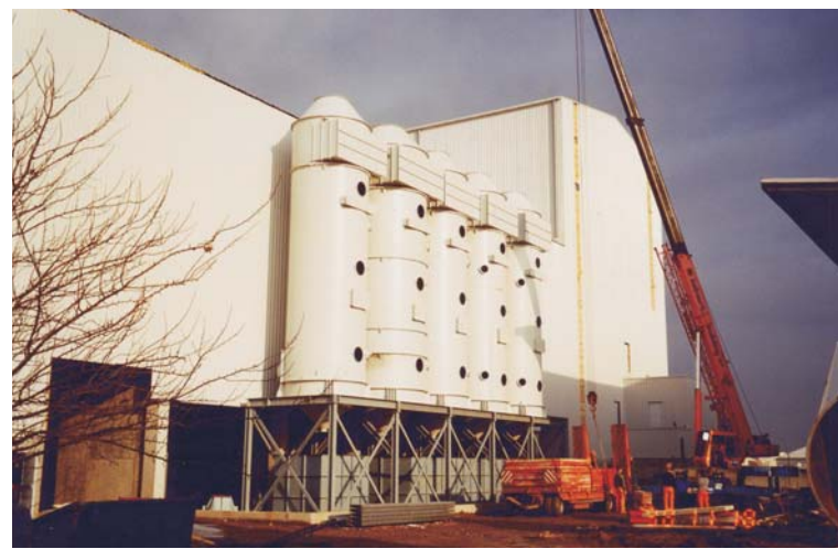
Pralniki za izločanje vlaken steklene volne in fenola (objekt ISOGLASS Belgija)
