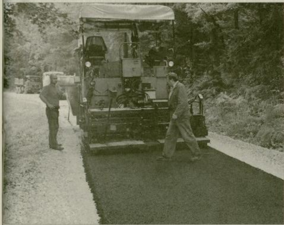
Pri asfaltiranju ceste v zaselku Podvin.
