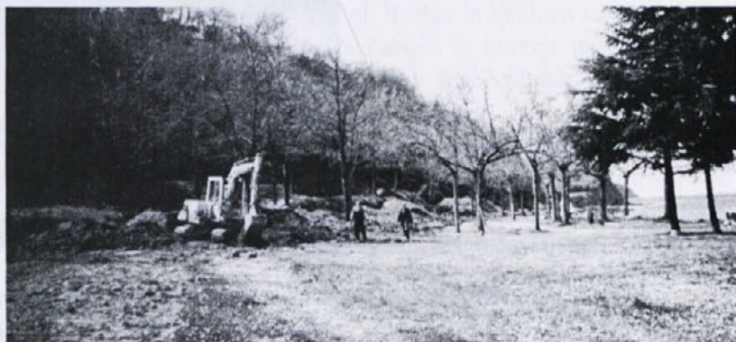
Plažo v Simonovem zalivu so prekopali, ko so tam priključili kanalizacijske cevi z Belvederja. Dela so zdaj že končali.
