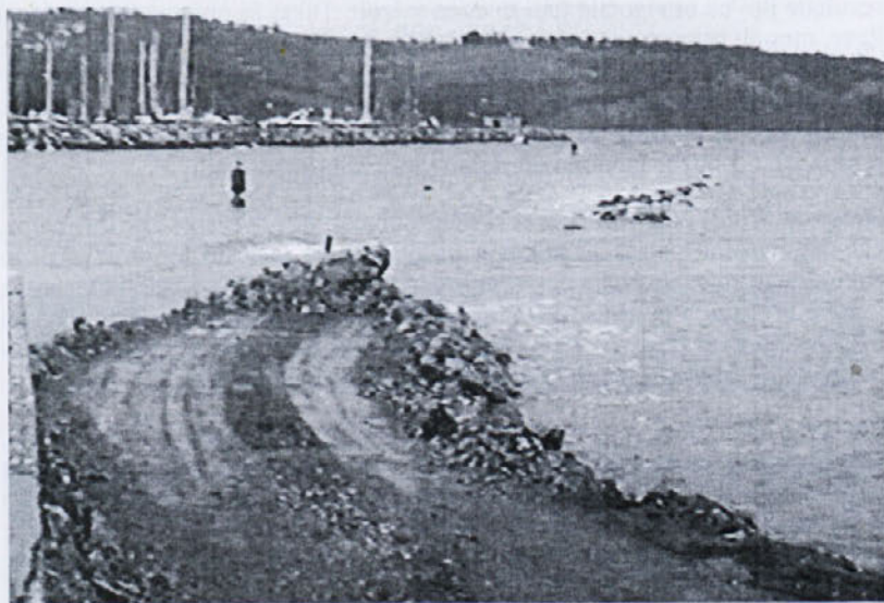
Tretji valobran bo v kratkem "pogledal" iz vode. Izvajalci del imajo še slaba dva meseca časa, potem bodo zaradi turistične sezone in zaradi posedanja materiala dela do zime prekinili.
