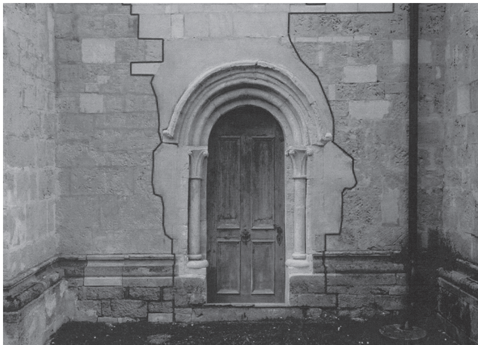
5. Špitalič, c. Marijinega obiskanja, rekonstrukcija severnega stranskega portala s sedanjim južnim (fotomontaža Robert Peskar)
