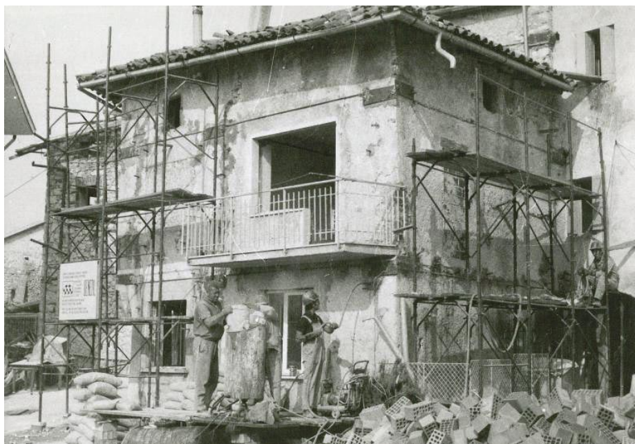
Slika 4 • Hiša, ki jo je po majskem potresu leta 1976 v Benečiji utrdila ekipa ZRMK, je septembrski potres istega leta prestala brez poškodb. (Fotografija: E. Vugrinec)
