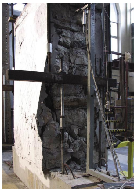
Slika 29 • Izbočenje obloge in razslojitev kamnitega zidu v porušni fazi preiskave (Fotografija: M. Tomažević)
