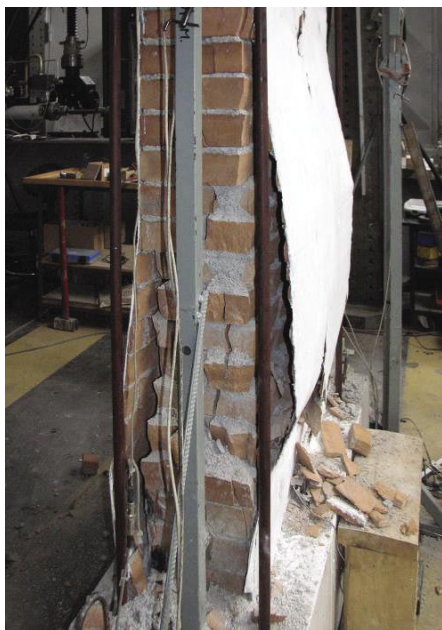
Slika 28 • Izbočenje obloge opečnega zidu, armirane s tkanino iz s steklenimi vlakni ojačenih polimerov v epoksidni matriki, pri porušitvi (Fotografija: M. Tomažević)
